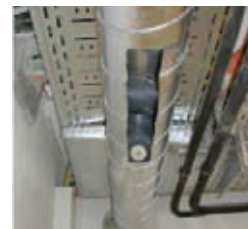
Rys. 5: Uszczelnienie przewodu instalacji wentylacyjno-klimatyzacyjnej (Źródło: IngBEU)
