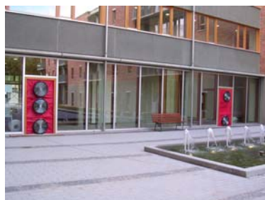
Pomiar BlowerDoor z 5 wentylatorami
