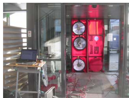
Pomiar BlowerDoor w dużych budynkach
